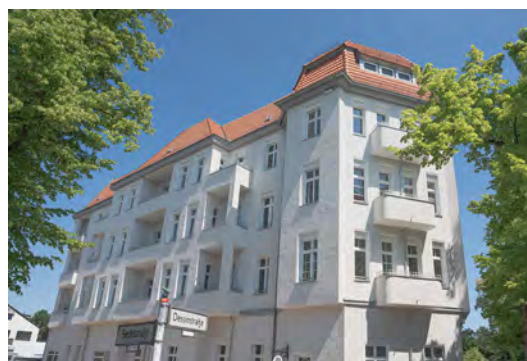
Hausfassade nach der Sanierung
