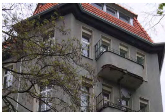
Hausfassade vor der Sanierung
