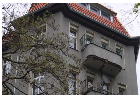
Hausfassade vor der Sanierung
